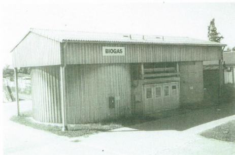
Biogasanlage der LLA Triesdorf / Mfr.
